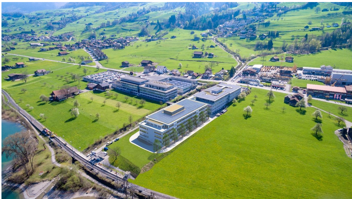
Uitzicht op het hoofdkantoor van maxon motor in Sachseln vanaf zomer 2018. Vooraan bij het meer het nieuwe Innovation Center. - Visualisierung Plus Architekten AG
